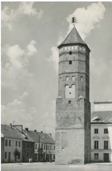
Pułtusk, wieża ratuszowa, widok od strony południowej.
