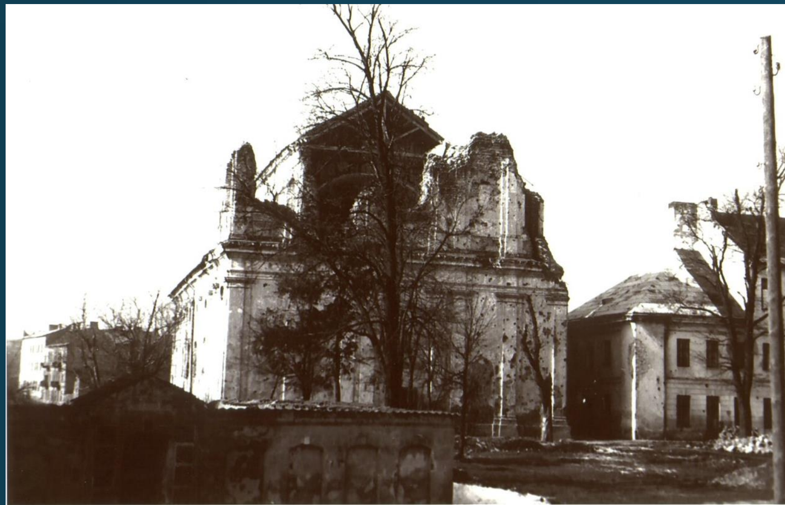
Zniszczona w wyniku bombardowania fasada kościoła jezuickiego, lata 1945-1948. Zbiory prywatne p. J. Gryca.
