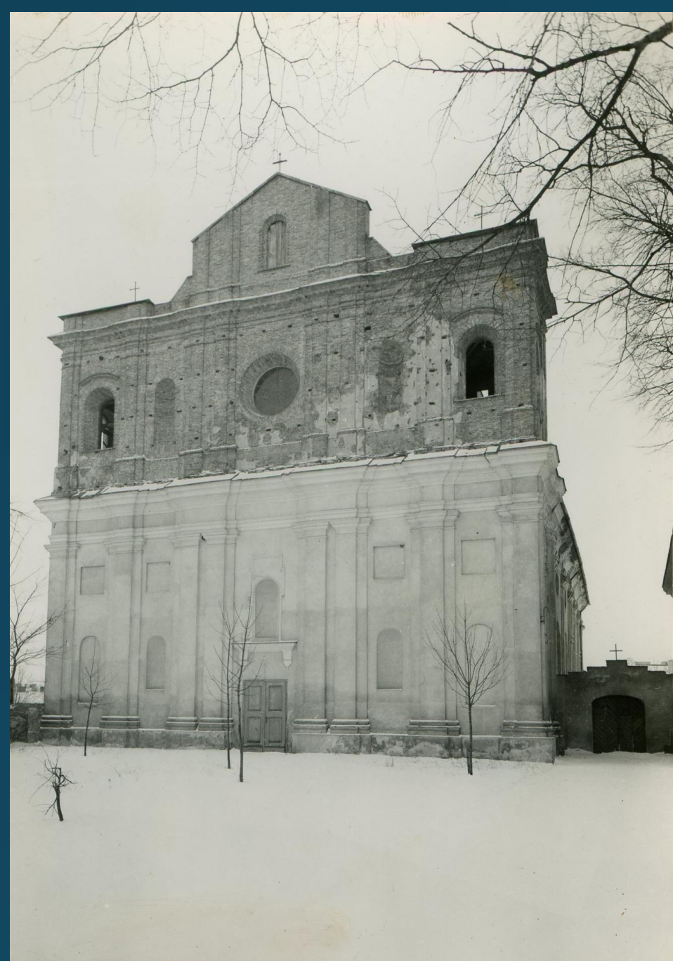
Fasada kościoła, 1957 r. Fot. M. Sulimierska. Zbiory prywatne p. J. Gryca.
